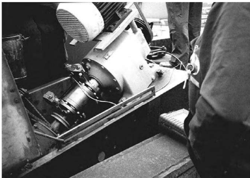
Установка для очистки воды
